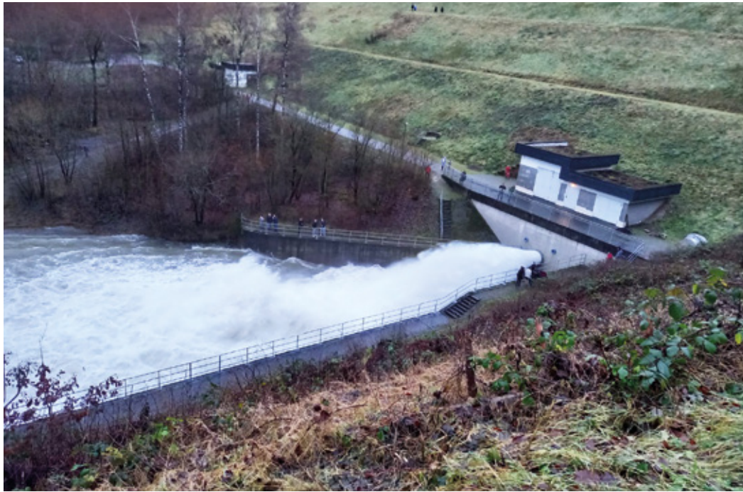
Bei Hochwasser davongespülte Gartenabfälle können Probleme verursachen.
