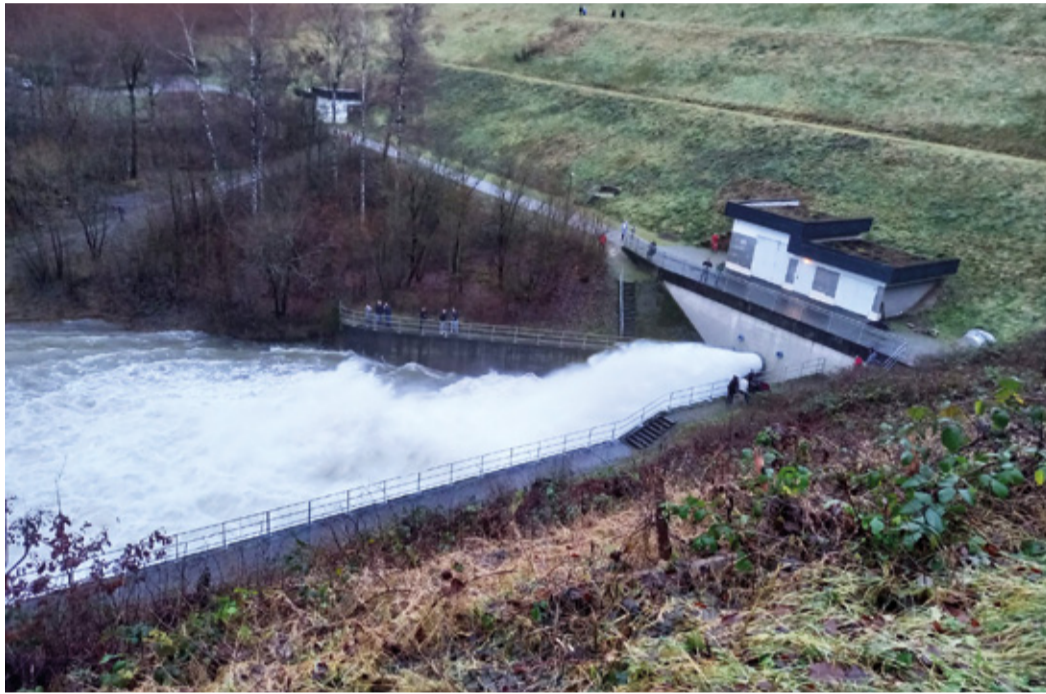
Bei Hochwasser davongespülte Gartenabfälle können Probleme verursachen.
