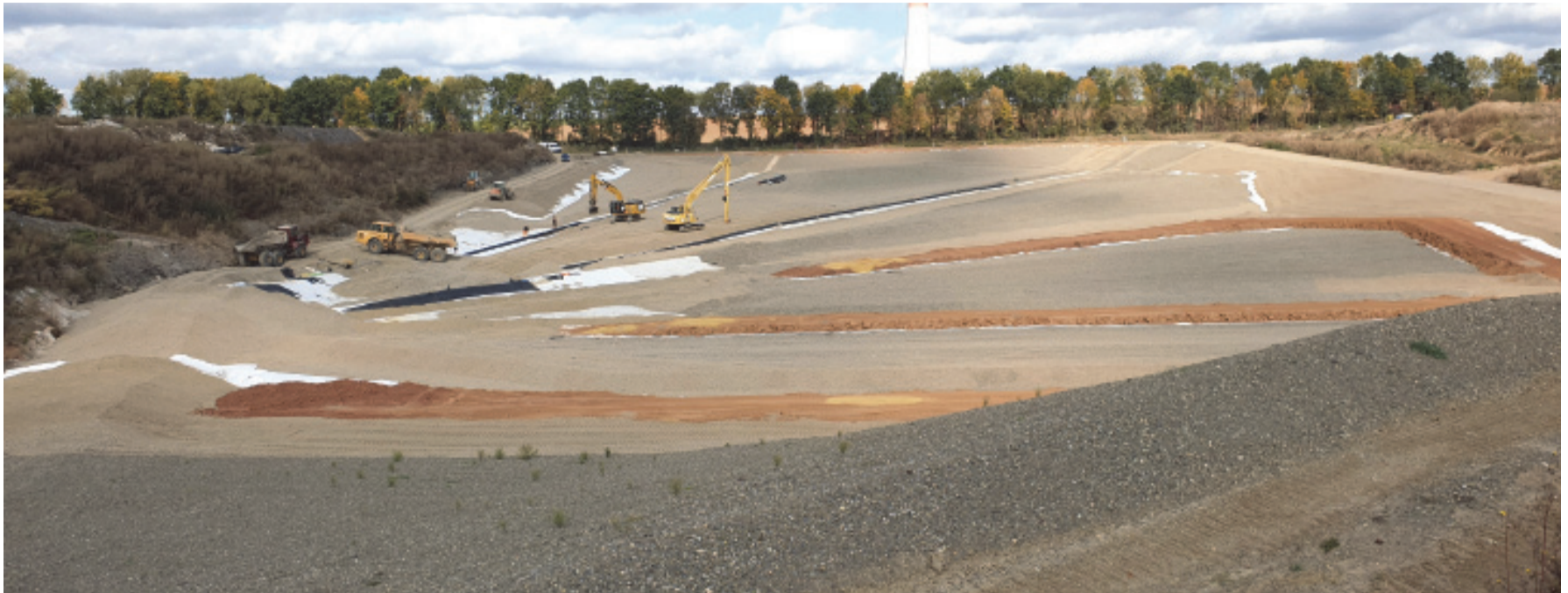
Vorne: Die Fahrstraßen zur Erstellung der Kiesrigolen über den Sickerwasserdrainageleitungen. In der Mitte sieht man, wie die Sandschutzmatte verlegt wird. Anschließend wurde der Drainagekies auf der Kunststoffdichtungsbahn am Sickerwasserzentralbauwerk eingebaut. Hinten: Verlegung der Sickerwasserdrainageleitung 1 vom Zentralbauwerk zur Böschung an der Deponieringstraße Foto: Sietloff
