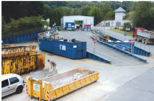
Recyclinghof der Entsorgungsanlage Hattorf am Harz Foto: Bleiß
