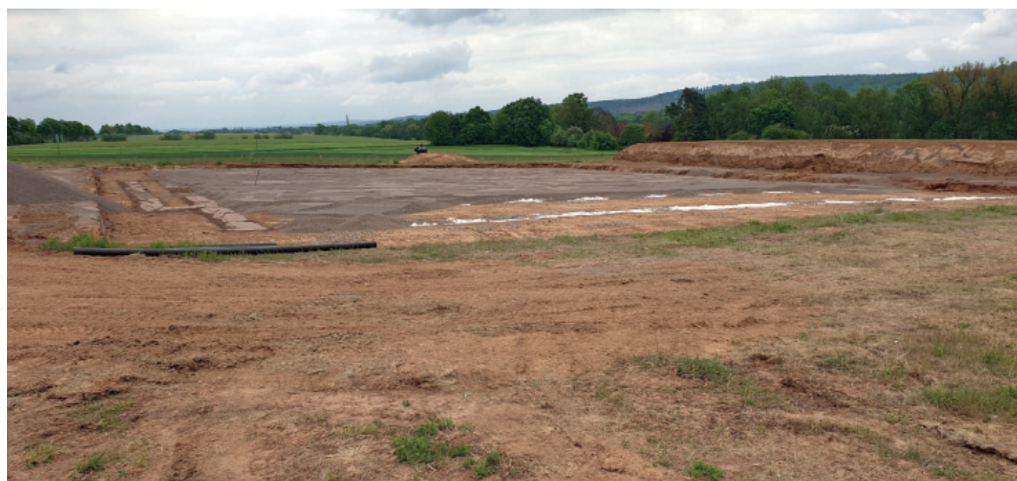
Gasverteilerschicht der Methanoxidentsfelder (MOF) im Aufbau
