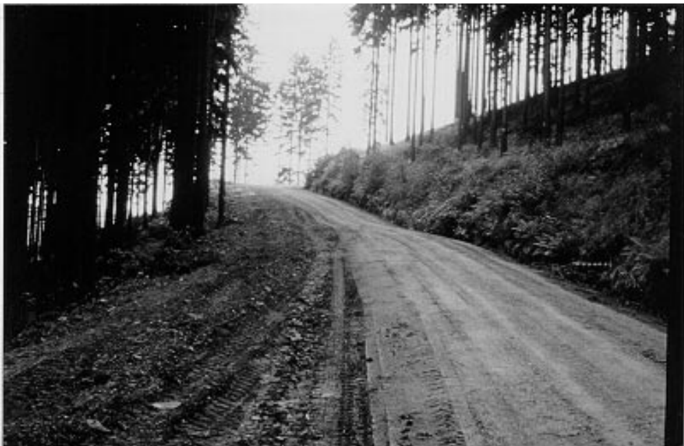
Foto 79: An breitere Forstwege sowie sonstige Innenränder zu waldfreien Bereichen hin gehören Waldränder reduzierter Tiefe. Die rechtsseitige Böschungsbegrünung ist zwar ein Ansatz, jedoch ist diese Tiefe im Fichtenhochwald zu gering. Linksseitig und zur freien Fläche im Hintergrund fehlt der Waldrand völlig. Dadurch ist das Waldinnenklima bis in größere Tiefen gestört.
